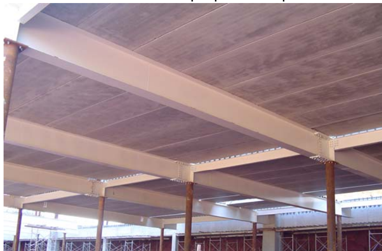
Figura 5 - Acabamento inferior da laje Alveolar
