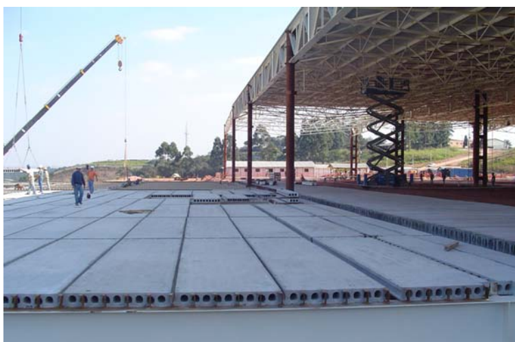
Figura 3 –Redução da mão-de-obra
