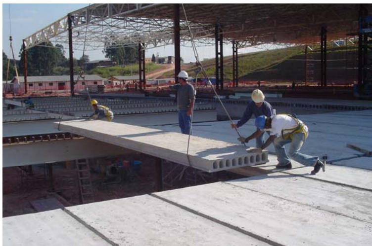
Figura 2 – Montagem dos Painéis Alveolares
