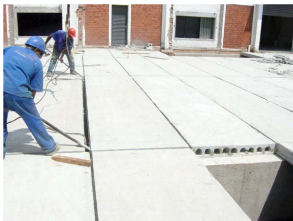
Figura 16 – Placa sendo deslocada até a sua posição
