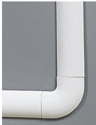
Exemplo de Duto Slim instalado em parede.
