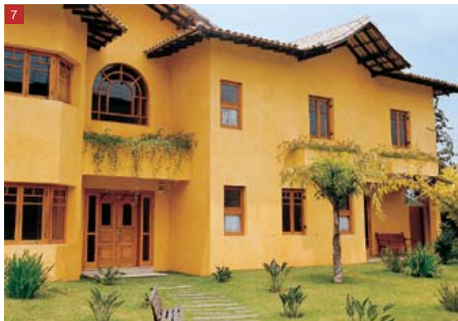
Pintura com cal feita com 1 kg de Pó Xadrez Amarelo em 8 kg de cal.
